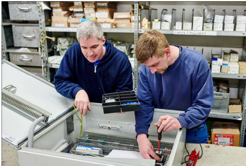
Mit den eigenen Schaltschränken kann das Unternehmen individuelle Regelungen und Steuerungen realisieren.
